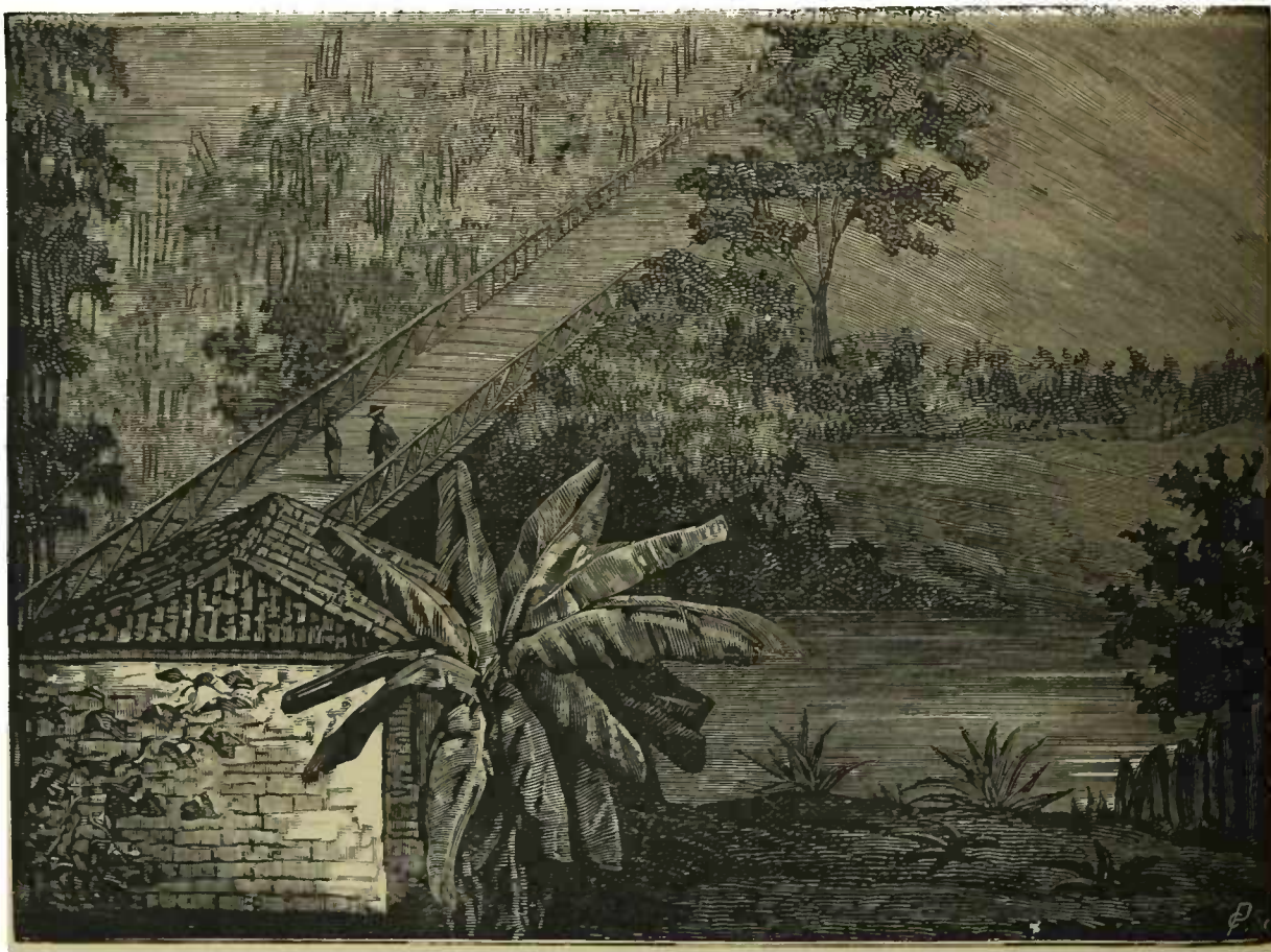
VISTA DO HOTEL GOYANO, NO POMBA
