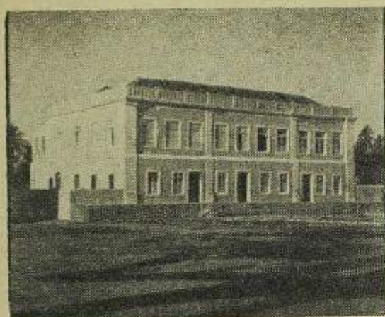
O EDIFÍCIO QUE SEGUNDO CONSTA, SE VAI ADQUIRIR PARA INSTALAÇÕES HOSPITALARES
