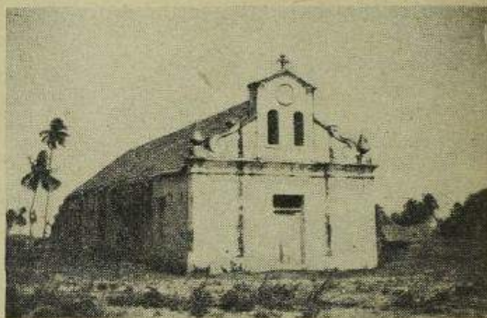
IGREJA DE SÃO LUÍS GONZAGA, DE QUERIMBA. — CONSTRUÍDA HÁ 50 ANOS. — (Foto Soeiro)
